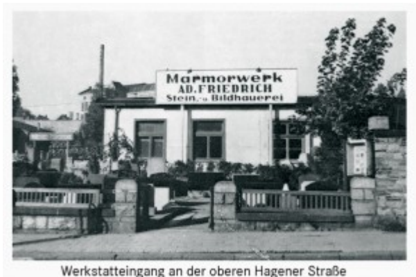
Werkstatteingang an der oberen Hagener Straße
